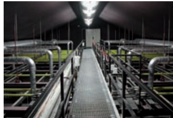
Ein Rohrwellenzug im Kulturzentrum Mersch hat eine Tragkraft von 300 kg
